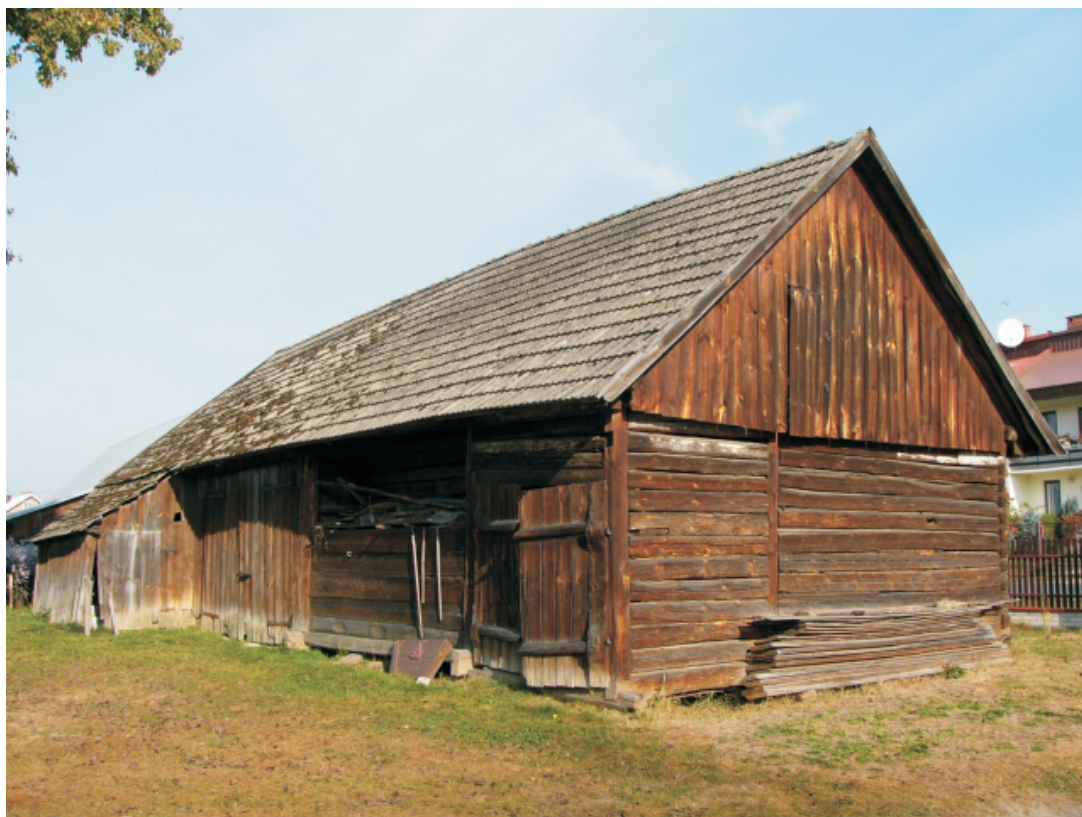
28.Obiekt: Stodoła II w zagrodzie nr 402, użytkowanie - rolnictwo, budynek drewniany, datowany na pocz. XX w., działka ewid. nr 1792, adres - Wola Zarczycka nr 402, własność - prywatna, stan zachowania - zaniedbany, uwagi: dach kryty dachówką, Karta Gminnej Ewidencji Zabytków nr: 31/1719
