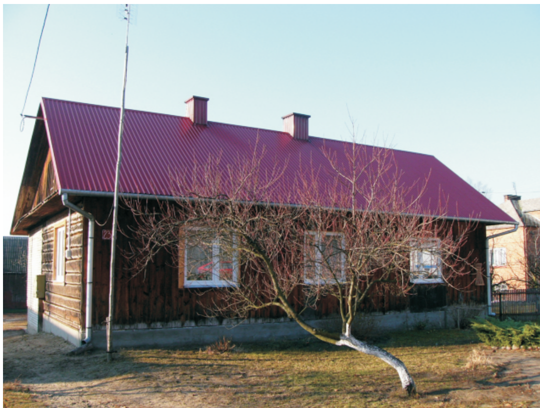
10. Obiekt: Dom nr 232, użytkowanie - mieszkalne, budynek drewniany, datowany na 1909 r., działka ewid. nr 9450, adres - Wola Zarczycka nr 232, własność - prywatna, stan zachowania - bardzo dobry, uwagi: rozbudowany o część ze ścianami ceglany, zmiana dachu ok. 1985 r., kryty blachą, Karta Gminnej Ewidencji Zabytków nr: 13/1719
