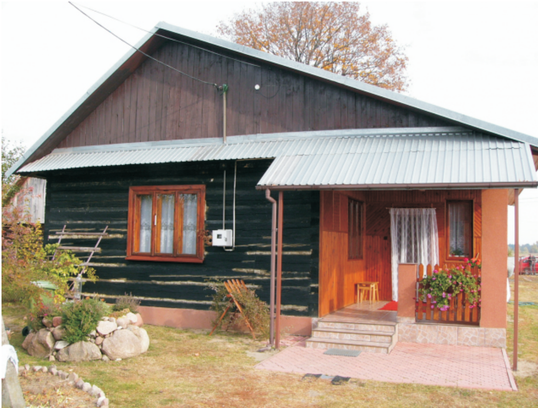
15. Obiekt: Dom nr 591, użytkowanie - mieszkalne, budynek drewniany, datowany na koniec XIX w., działka ewid. nr 14255, adres - Wola Zarczycka nr 591, własność - prywatna, stan zachowania - bardzo dobry, uwagi: rozbudowany o ganek i przebudowany dach. Dach kryty blachą, Karta Gminnej Ewidencji Zabytków nr: 18/1719
