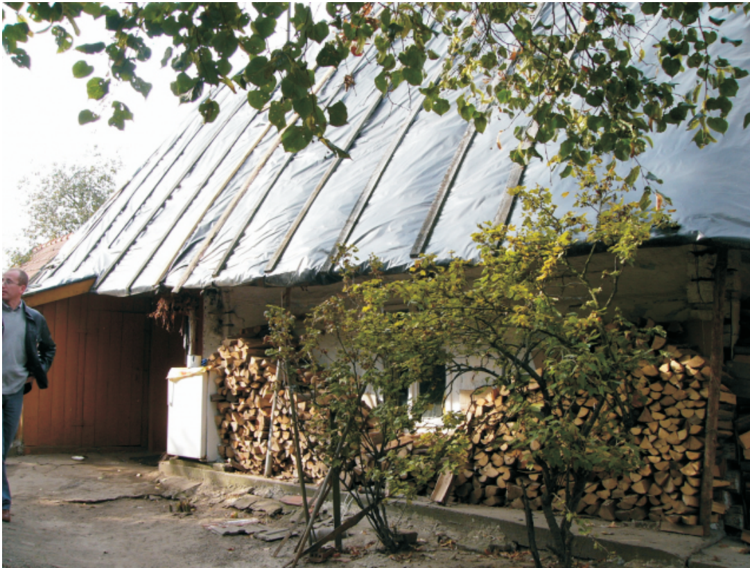
19. Obiekt: Dom nr 74, użytkowanie - mieszkalne, budynek drewniany, datowany na k. XIX w., działka ewid. nr 13315, adres - Wola Zarczycka nr 74, własność - prywatna, stan zachowania - zły, uwagi: przykryty folią, Karta Gminnej Ewidencji Zabytków nr: 22/1719
