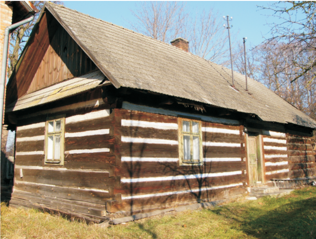
21. Obiekt: Dom nr 311, użytkowanie - mieszkalne, budynek drewniany, datowany na 1923 r., działka ewid. nr 1662, adres - Wola Zarczycka nr 311, własność - prywatna, stan zachowania - zaniedbany, uwagi: dach kryty dachówką, Karta Gminnej Ewidencji Zabytków nr: 24/1719
