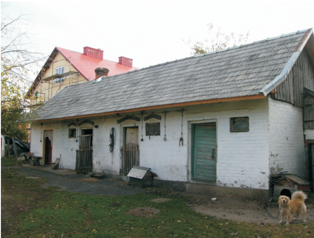
12. Obiekt: Stajnia w zagrodzie nr 427, użytkowanie - rolnictwo, budynek murowany, datowany na ok. 1920 r., działka ewid. nr 11866, adres - Wola Zarczycka nr 426, własność - prywatna, stan zachowania - zaniedbany, uwagi: dach kryty blachą, Karta Gminnej Ewidencji Zabytków nr: 15/171
