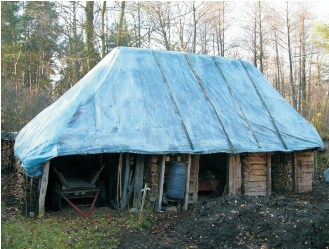
16. Obiekt: Stodoła ze stajnią w zagrodzie nr 777, użytkowanie - pomocnicze, budynek drewniany, datowany na XIX/XX w., działka ewid. nr 3193, adres - Wola Zarczycka nr 777, własność - prywatna, stan zachowania - bardzo zły, uwagi - kryty folią, Karta Gminnej Ewidencji Zabytków nr: 19/1719
