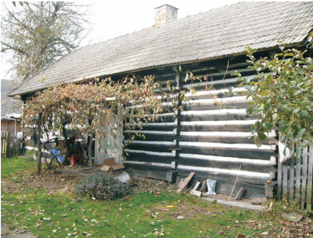
17. Obiekt: Dom nr 22, użytkowanie - mieszkalne, budynek drewniany, datowany na 1907 r., działka ewid. nr 13374, adres - Wola Zarczycka nr 22, własność - prywatna, stan zachowania - zaniedbany, uwagi: przebudowa dachu w 1985 r., kryty dachówką, Karta Gminnej Ewidencji Zabytków nr: 20/1719
