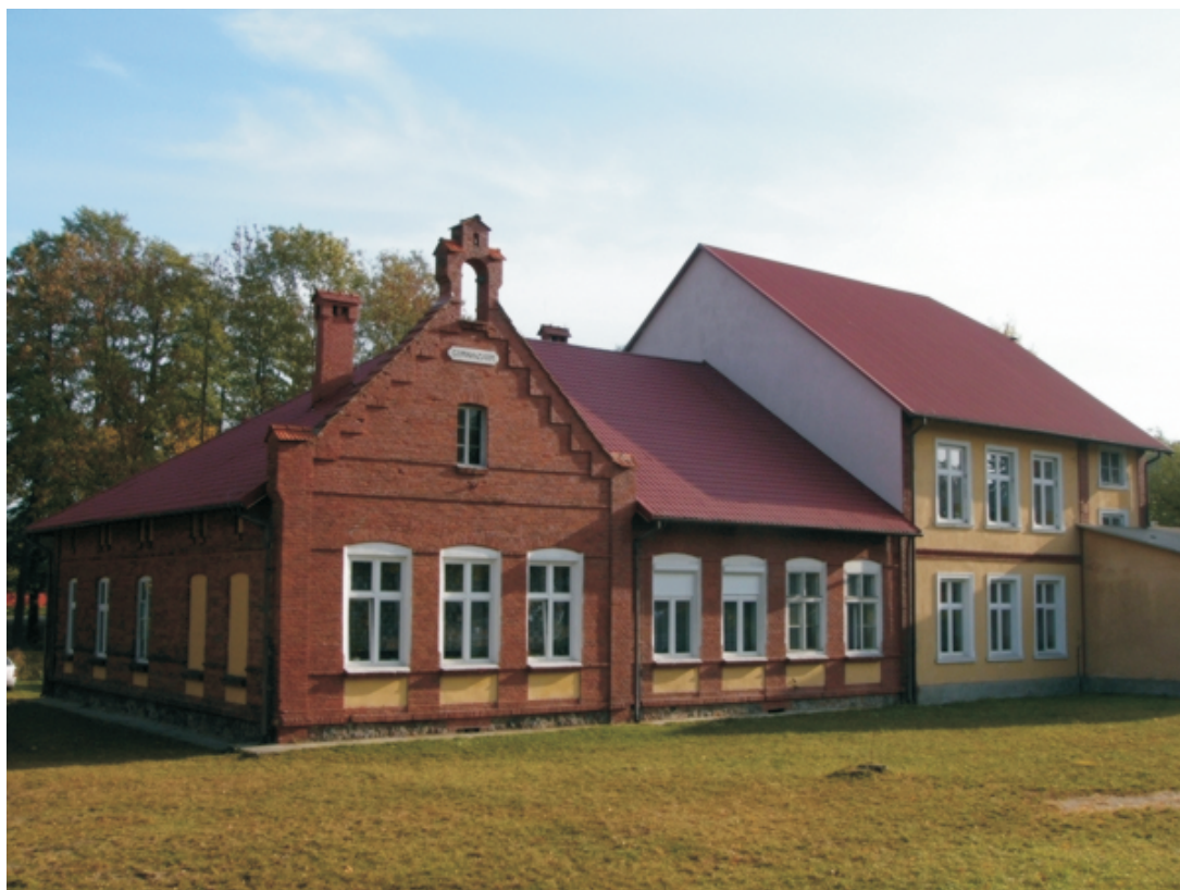
29. Obiekt: szkoła, obecnie budynek Gimnazjum, budynek murowany, datowany na 1900 r., adres - Wola Zarczycka nr 128, własność - komunalna, stan zachowania - bardzo dobry,
