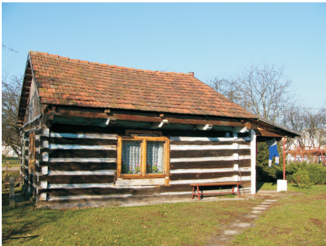
3.Obiekt: Dom nr 91, użytkowanie - mieszkalne, budynek drewniany, datowany na 1919 r., działka ewid. nr 79, adres: Łukowa 91, własność - prywatna, stan zachowania - zaniedbany, Karta Gminnej Ewidencji Zabytków nr: 39/1719
