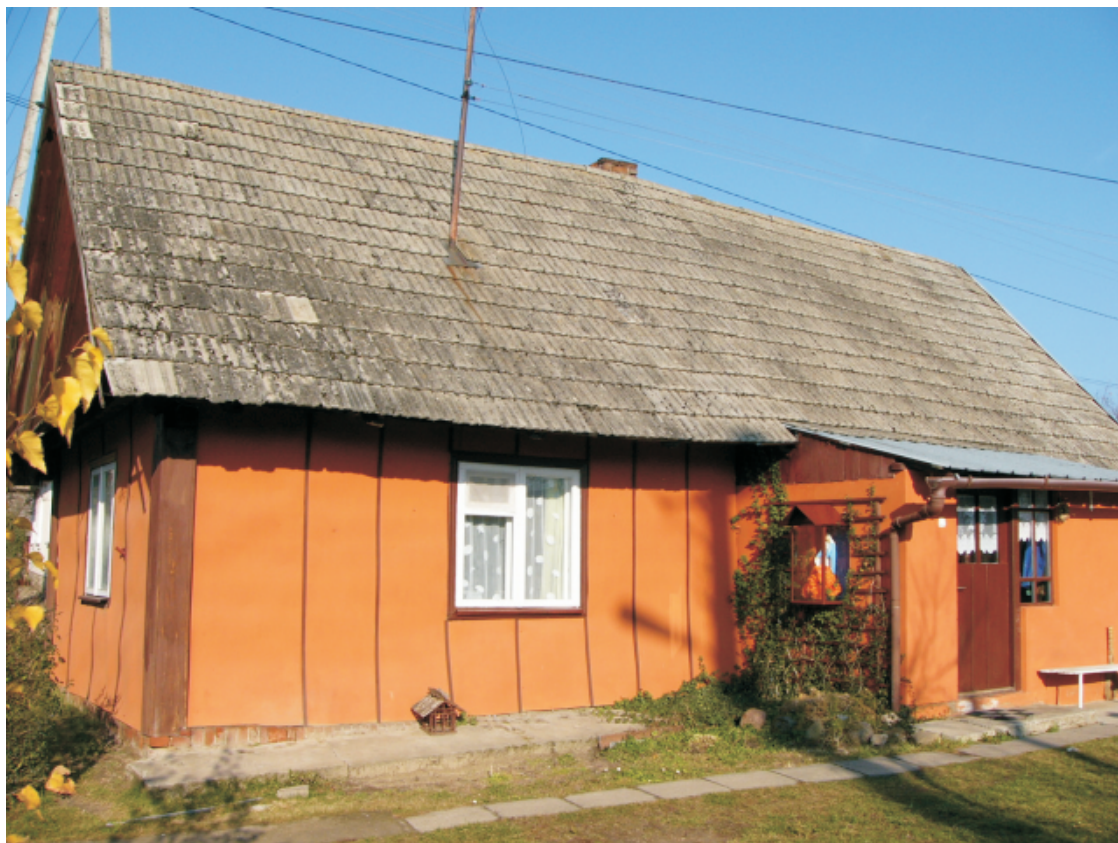
7. Obiekt: Dom nr 1201, użytkowanie - mieszkalne, budynek drewniany, datowany na 1926 r., adres: Sarzyna nr 1201, działka ewid. nr 1866, własność - prywatna, stan zachowania - zaniedbany, uwagi: ściany obite płytami, dach kryty dachówką, dobudowany ganek, częściowo wykonano ocieplenie i elewację, Karta Gminnej Ewidencji Zabytków nr: 76/1719
