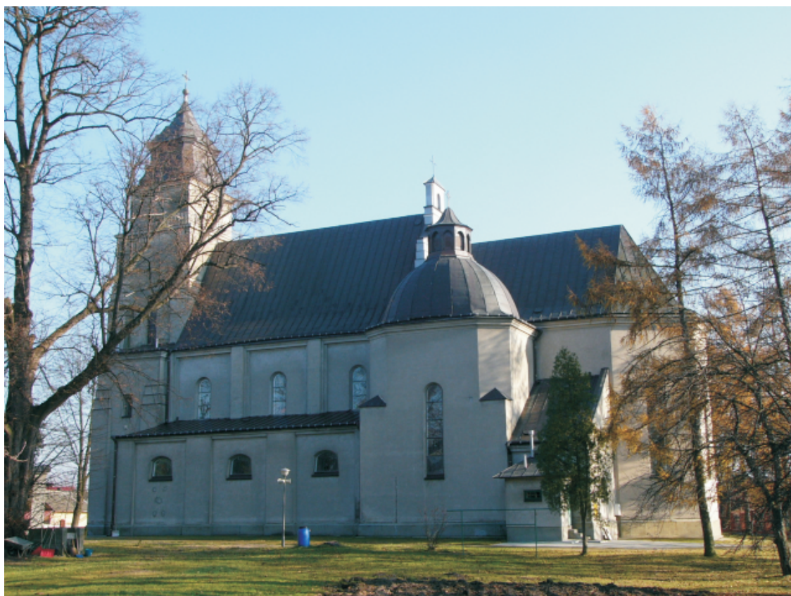
1. Obiekt: Kościół w zespole kościoła parafialnego p.w. św. Sebastiana, użytkowanie - kultowe, obiekt murowany, datowany na 1928 r., działka ewid. nr 2619, własność - wyznaniowa, stan zachowania - bardzo dobry, uwagi: proj. arch. Wawrzyniec, Dańczak, budowali: Józef Zawilski i Karol Gdula z Leżajska, remont w 1969 r., Karta Gminnej Ewidencji Zabytków nr: 70/1719
