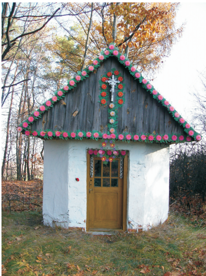
3.Obiekt: Kapliczka MB, użytkowanie - kultowe, obiekt murowany, datowany na XVIII w., działka ewid. nr 2189, lokalizacja: przy drodze Leżajsk-Rudnik, własność - komunalna, stan zachowania - zaniedbany, informacja o ochronie - karta ewidencyjna zielona, uwagi - dach zmieniony przed 1939 r., Karta Gminnej Ewidencji Zabytków nr: 65/1719
