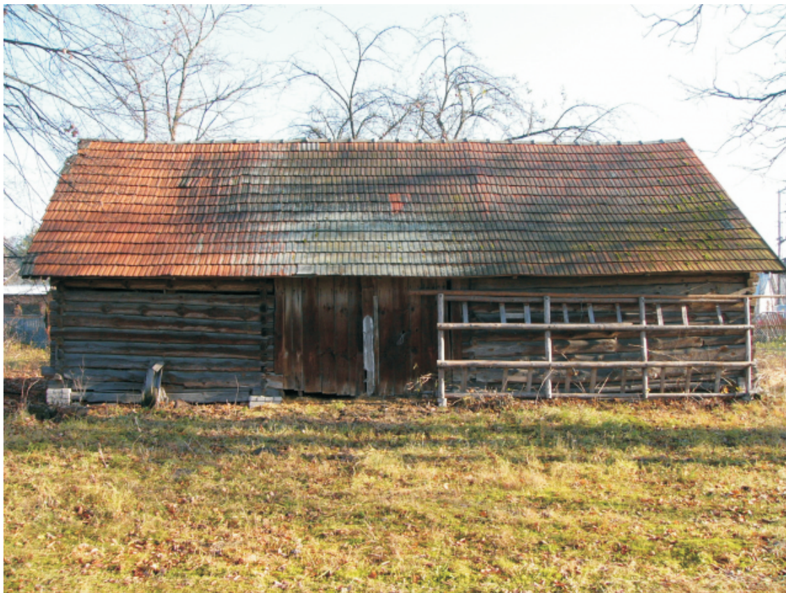
5. Obiekt: Stodoła w zagrodzie nr 22, użytkowanie - pomocnicze, budynek drewniany, datowany na ok. 1915 r., działka ewid. nr 2076, adres: Jelna nr 22, własność - prywatna, stan zachowania - zły, uwagi - dach kryty dachówka, Karta Gminnej Ewidencji Zabytków nr: 67/1719
