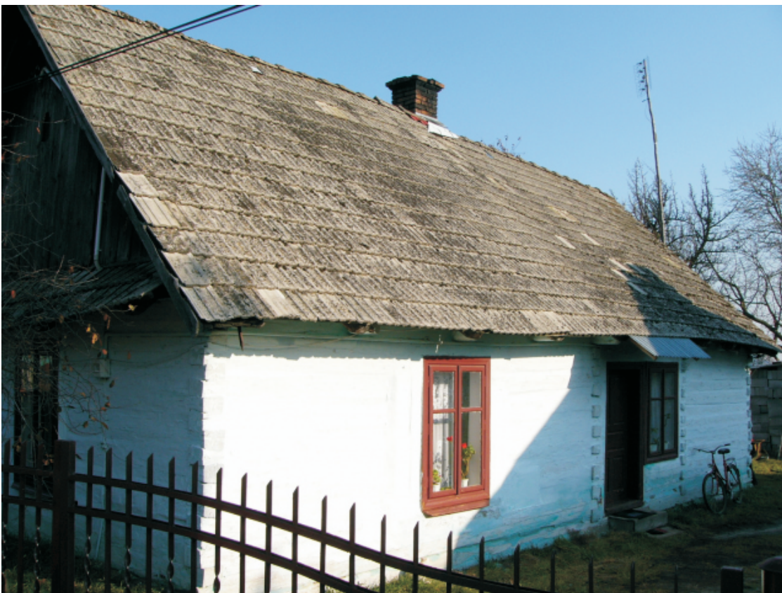
6. Obiekt: Dom nr 103, użytkowanie - mieszkalne, budynek drewniany, datowany na 1915 r., działka ewid. nr 613, adres: Tarnogóra nr 103, własność - prywatna, stan zachowania - zaniedbany, uwagi: dach kryty dachówką, Karta Gminnej Ewidencji Zabytków nr: 60/1719
