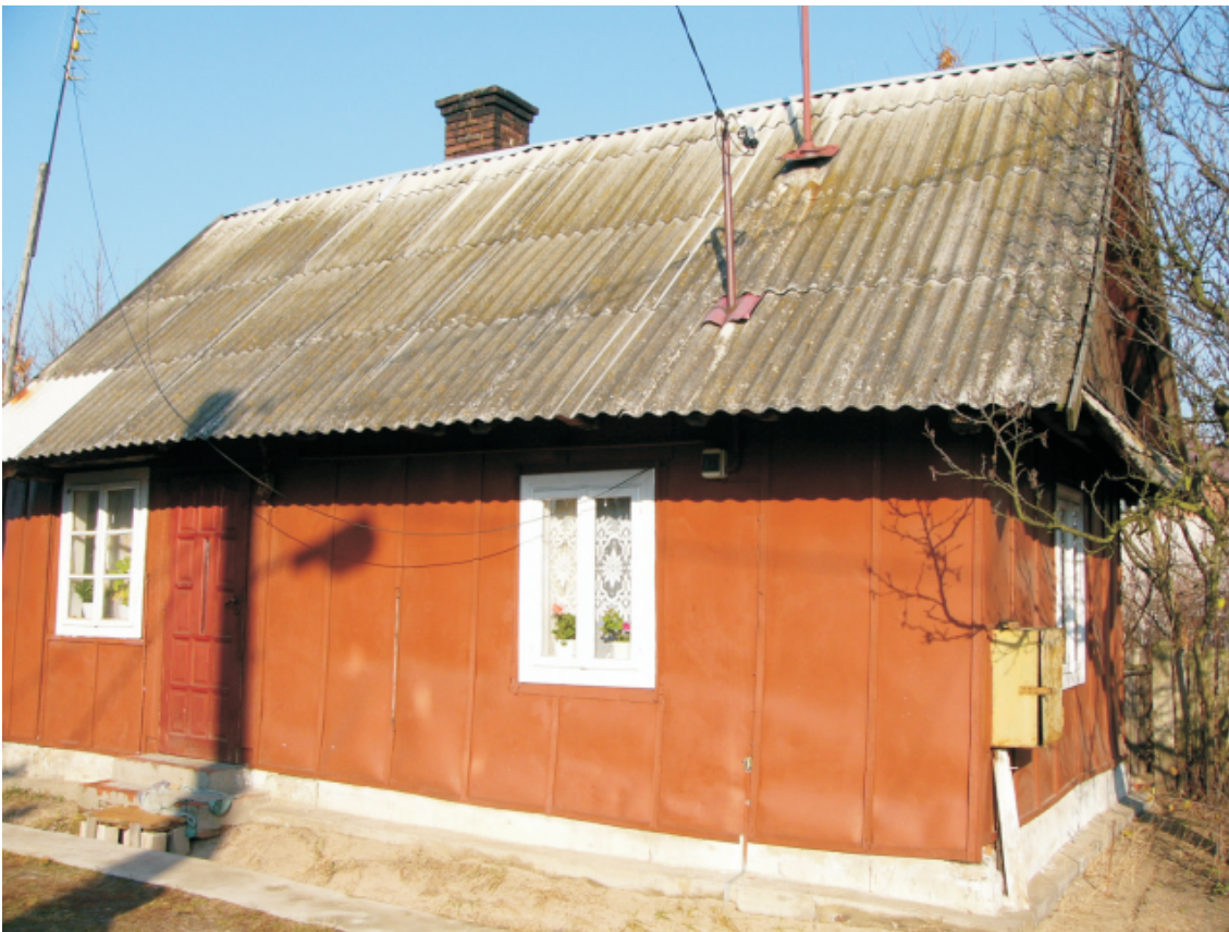
5. Obiekt: Dom nr 12, użytkowanie - mieszkalne, budynek drewniany, datowany na 1919 r., działka ewid. nr 22, adres: Tarnogóra nr 12, własność - prywatna, stan zachowania - zaniedbany, uwagi: ściany obłożone płytami, dach kryty eternitem, Karta Gminnej Ewidencji Zabytków nr: 59/1719
