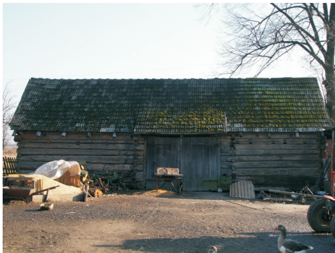
4. Obiekt: Stodoła w zagrodzie nr 129, użytkowanie - rolnictwo, budynek drewniany, datowany a 3 ćw. XIX w., działka ewid. nr 627/1, adres: Tarnogóra nr 129, własność - prywatna, stan zachowania - zaniedbany, uwagi: dach kryty dachówką, Karta Gminnej Ewidencji Zabytków nr: 58/1719
