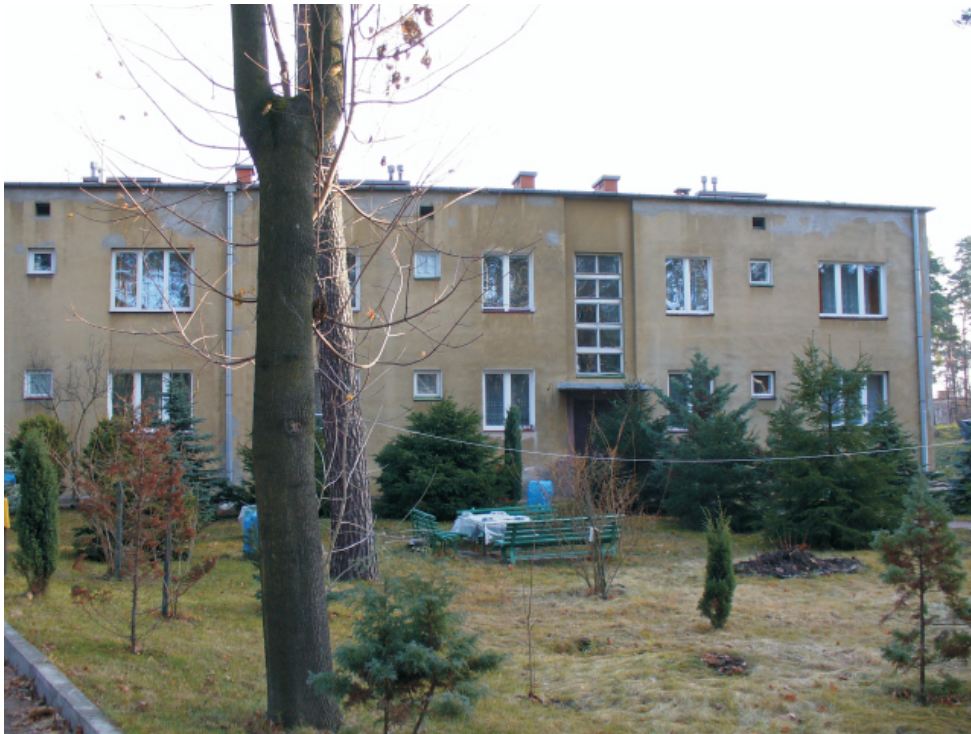
11.Obiekt: WNO "Nitroza" - osiedle mieszkaniowe, blok 2 klatkowy, funkcja - budynek mieszkalny, budynek murowany, datowany na lata 1937-1939, działka ewid. nr 2/27, adres: Chemików 8, własność - komunalna, stan zachowania - zaniedbany, Karta Gminnej Ewidencji Zabytków nr: 50/171
