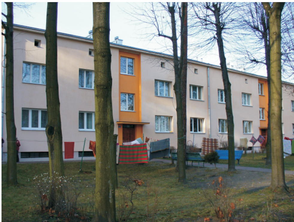
9. Obiekt: WNO "Nitroza" - osiedle mieszkaniowe, blok 2 klatkowy, funkcja - budynek mieszkalny, budynek murowany, datowany na lata 1937-1939, działka ewid. nr 2/28, adres: Braci Śniadeckich 4, własność - komunalna, stan zachowania - bardzo dobry, Karta Gminnej Ewidencji Zabytków nr: 48/1719
