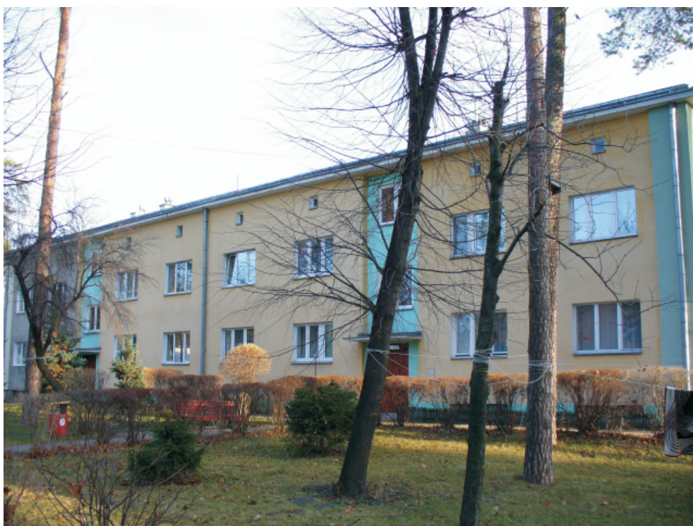
10. Obiekt: WNO "Nitroza" - osiedle mieszkaniowe, blok 2 klatkowy, funkcja - budynek mieszkalny, budynek murowany, datowany na lata 1937-1939, działka ewid. nr 2/32, adres: Braci Śniadeckich 9, własność - komunalna, stan zachowania - bardzo dobry, Karta Gminnej Ewidencji Zabytków nr: 49/1719
